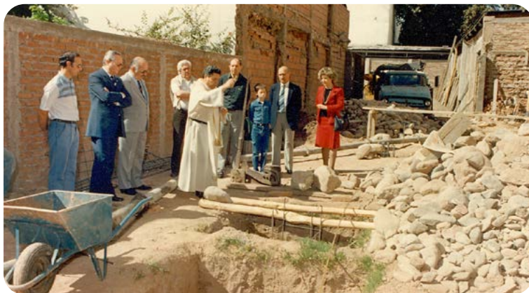
Bendición de los cimientos de la segunda etapa del primer edificio, 1987.
