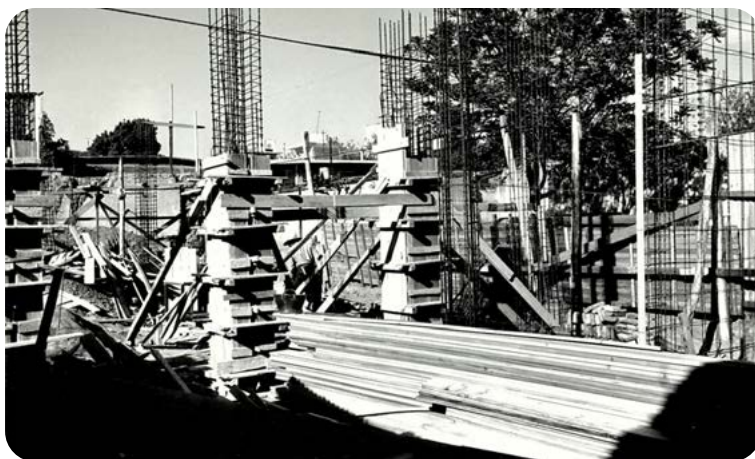
Primer edificio. Proceso de construcción, 1968 c.
