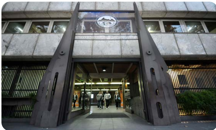
Fachada del edificio de Catamarca 147.
