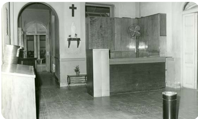
Casa Bianchi. Hall de distribución.
