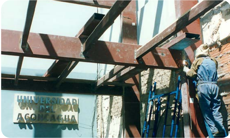
Armado del sistema constructivo "perfil".
