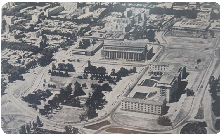
Vista aerea del Centro Cívico de Mendoza.
