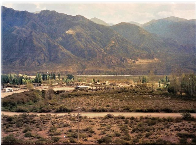
29. Potrerillos antes del Dique de contención de agua.
